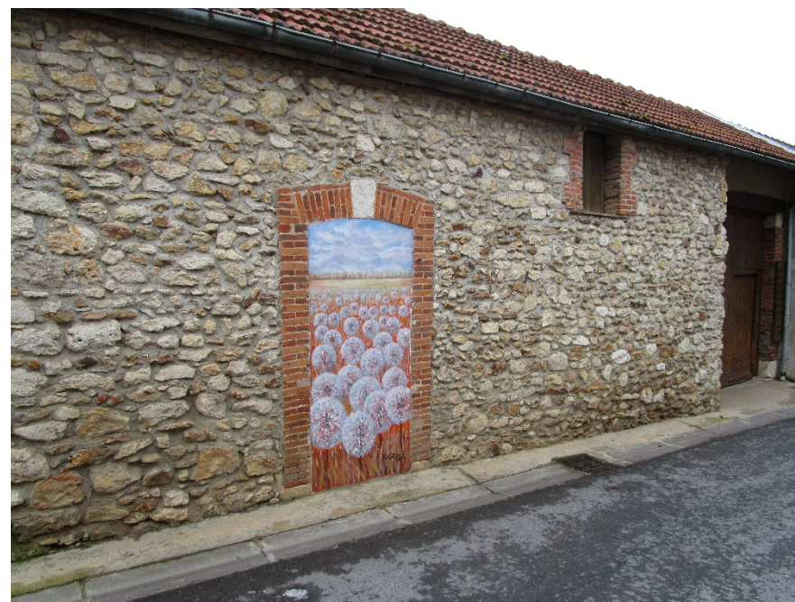
Figure 37 : bât en pierre calcaire grossière – centre-bourg
