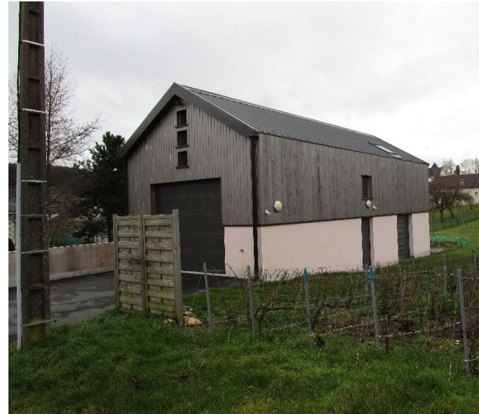
Figure 88 : hangar récent avec un bardage en bois gris
