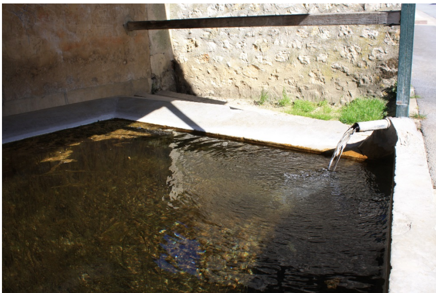
Figure 95 : bac du lavoir - Grande Rue
