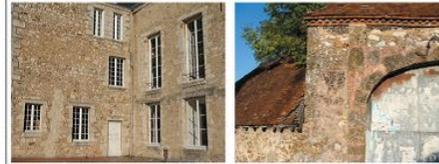
Pour le Tardenois, des blocs de pierres calcaires, associés à un mortier de rejointoiement de teinte plus foncée, donne une tonalité plus neutre.
