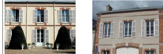
La présence des encadrements, des bandeaux et des nervures en brique, donne une richesse de couleur à la façade. Il est donc préférable de rester « neutre » dans la coloration, tant pour les enduits que pour les menuiseries.
