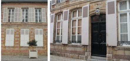
Il existe aussi des constructions, réalisées principalement au 19<sup>ème</sup> de style néoclassique, construites en brique avec des chaînages et des encadrements en pierre.
